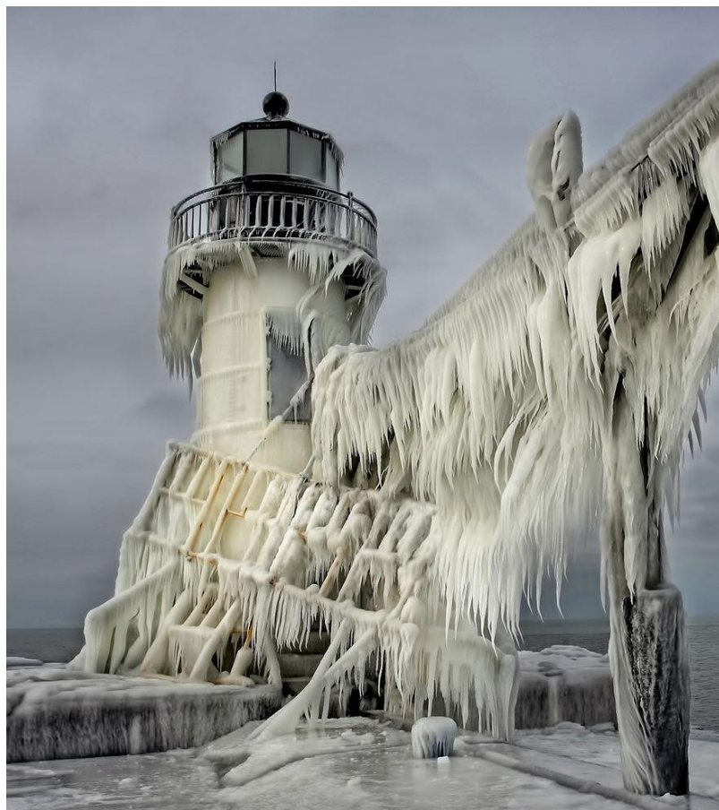
Maják na St. Joseph North Pier v Michiganu v zimě
